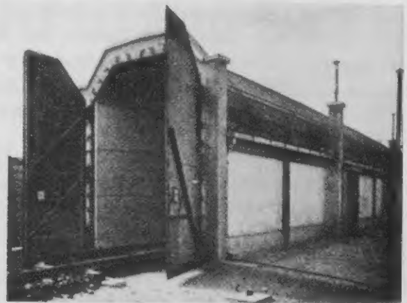
Abb. 39. Ansicht der Eisenbahn-Begasungskammer der Staatlichen Bahnen in Budapest. (Am hinteren Ende der Apparateraum mit Kreislaufanlage und Lüftungsgerät).
